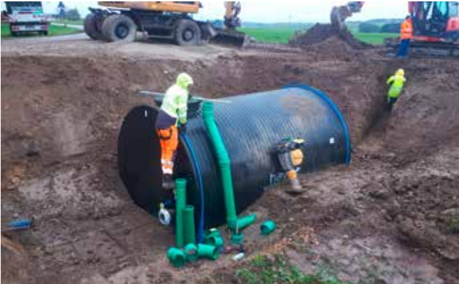
Foto: Bauarbeiten für einen Übergabeschacht an der neuen Trinkwasser-Verbundleitung zwischen Schonstett und Söchtenau.
